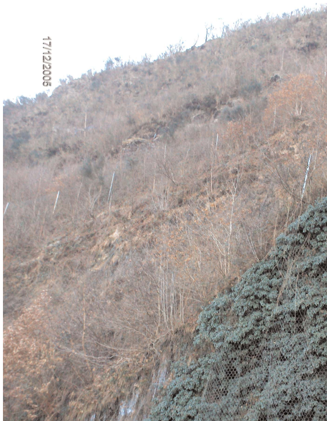
Fig. 6.- Revin : filets de protection permettant de retenir d'éventuelles chutes de blocs.
