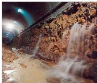
Figure 1. 80: Construction de la ligne 14 traversant la nappe du Lutétien sous la place Lachambeaudie (photo : RATP).
