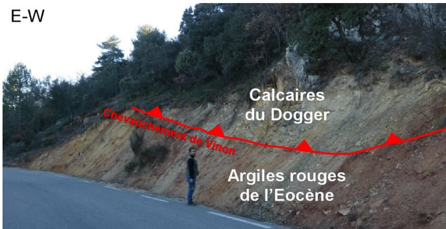
Figure 9 - Chevauchement de Vinon à proximité du village de St-Julien-le-Montagnié. Route départementale 35.
